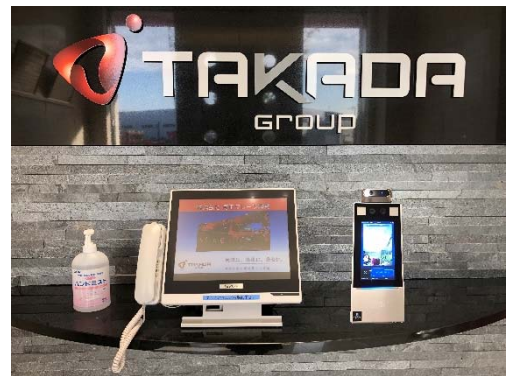
※本社ビル玄関口
