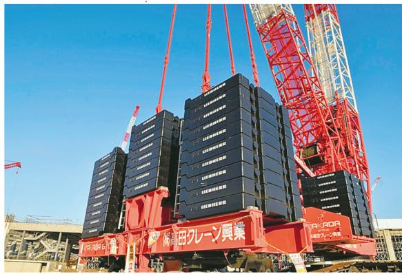
建物は5階建てで、延べ床面積は約32万平方㍍を予定。広大なプロアを利用できるのがメリットで、物流施設としては国内最大級という。現場では、1本20tを超す柱や梁をつるし、360度回転して運ぶクレーンが欠かせない。しかし、幅約4mもある建物の中央部まで届かないのがネックだった。そこで、運転席をはさんでアームの反対側に3500tもの重りを設置してバランスを取り、アームの稼働範囲を半径約80mから約130mに広げることに成功。建物の外側からでも作業ができるようになった。
