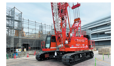
2026年8月27日 70セクローラークレーン (SCX700-3C5)
